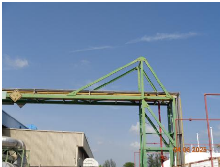
ภาพที่ 2.2-40 การยกกระดับแนวท่อ LPG ให้สูงจากระดับพื้น
