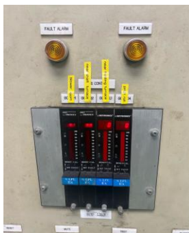
ภาพที่ 2.2-42 การติดตั้ง Gas Detector
